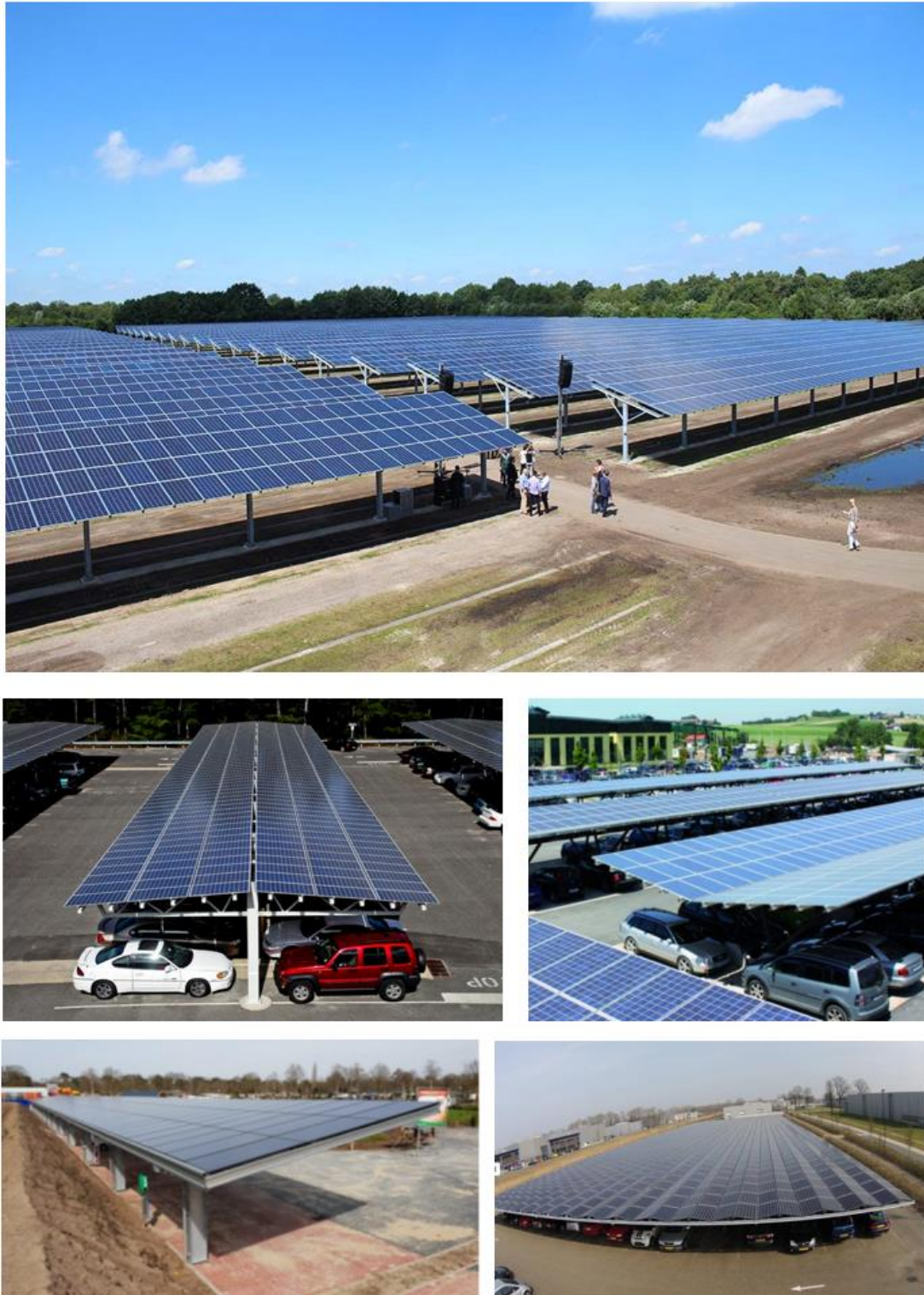
Figuur 3: Diverse ontwerpvarianten van zonnecarports, met bovenaan de carport(s) van het TT-circuit in Assen, met een totaal geïnstalleerd vermogen van 5,6 MWp.
