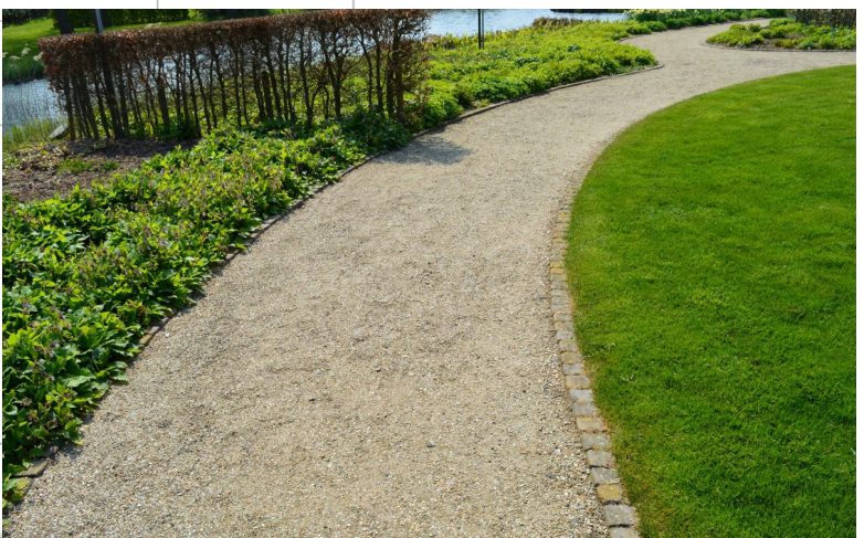
Referentie: halfverharding wandelpad
